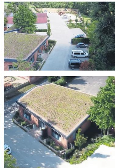
Rechtzeitig zum Jubiläum hat das in Dörverden-Stedebergen ansässige Unternehmen Rengstorff den neuen Firmensitz bezogen: das in Holzrahmenbauweise erstellte Gebäude trägt mit Gründach, Photovoltaikanlage, Pelletheizung und einer naturnahen Außenbegrünung zum Erhalt der Biodiversität bei.
